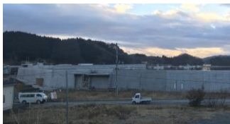
建設中の 防潮堤 (大船渡市)
